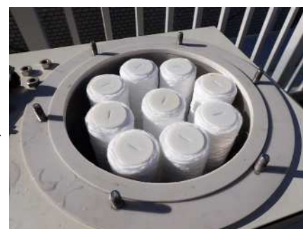
フィルター交換後 装置内部清掃後
