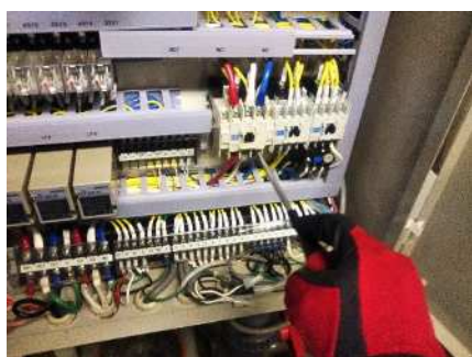
電装部の点検 部品交換など
